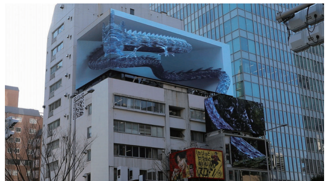
Fig. 4 複数の LED ビジョンの連携 (OMOSAN ビジョン 表参道ヒットビジョン 表参道交差点 2023年1月13日撮影)
